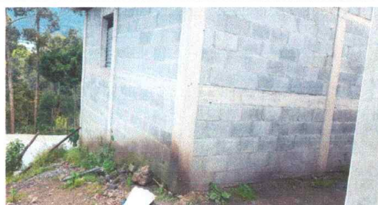
Foto 12: Repello en muro y cernido en muro.
