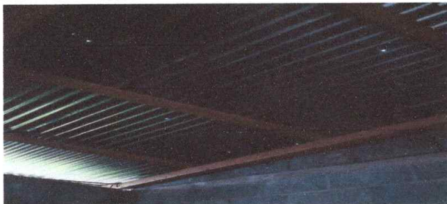
Foto; 1 Sustitución de lámina, por lámina troquelada aluzinc calibre 26
