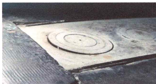
10. Sustrucción de estufa rural (completa) incluye chimenea y plancha de metal mas azulejo.
