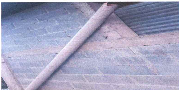
Foto; 7. Sustrucción de canal pvc y bajada de agua pluvial PVC3"
