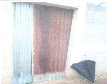
Foto 3. Sustitución de puerta
