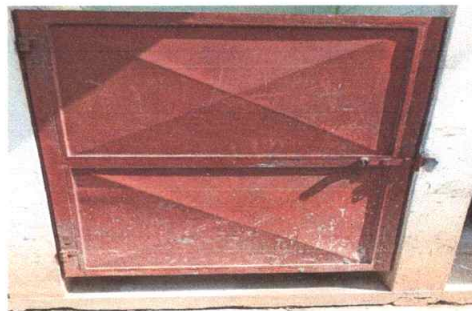
Foto 4: Sustitución puerta de servicio sanitario
